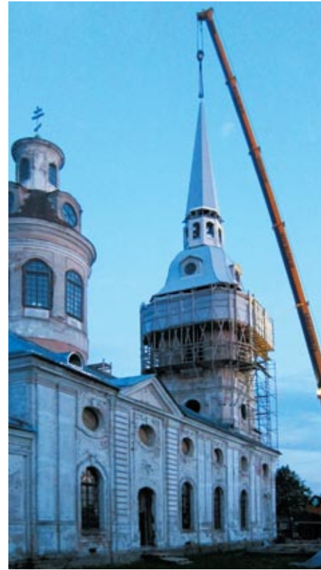
30 июня 2015 г. Подъем воссозданной конструкции купола с 14-метровым шпилем на колокольню собора Благовещения Пресвятой Богородицы в Шлиссельбурге
